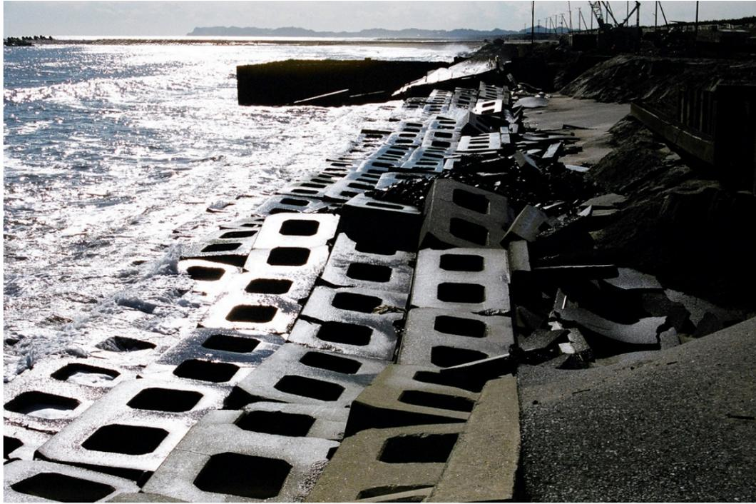
護岸前面の地盤沈下の例(千葉県)
